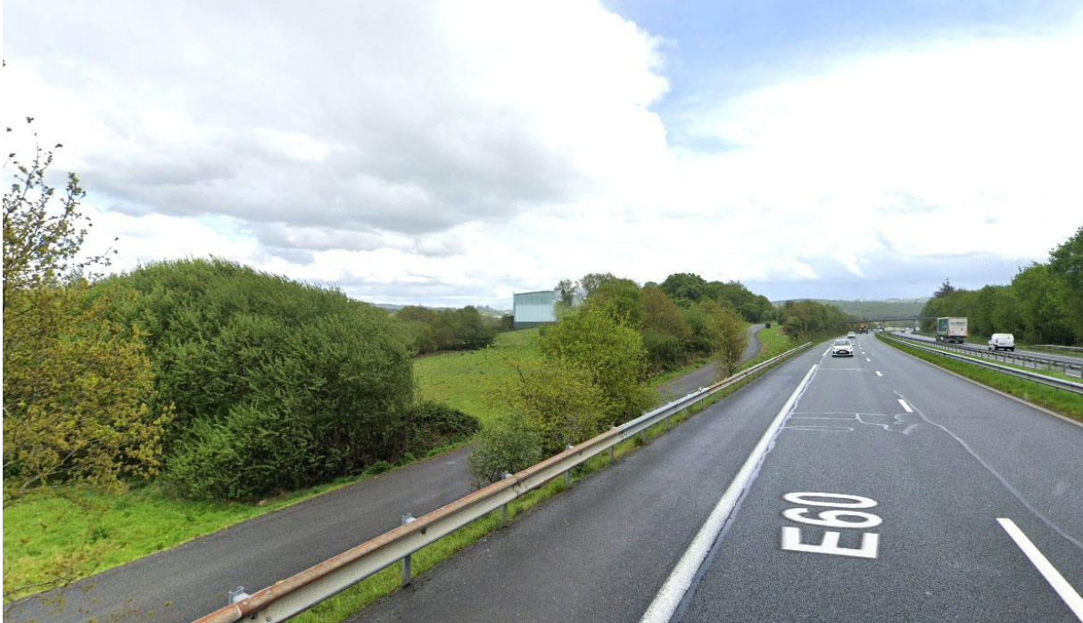
Figure 14 - Visibilité de l'installation depuis la RN 165
